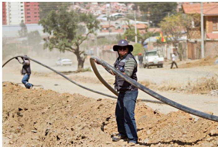
Tendido de SUPERTUBO®HDPE
