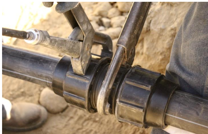
Detalle de instalación acople SUPERJUNTA®
